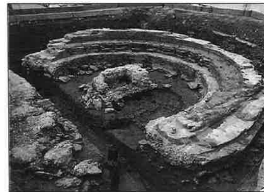
発見された「転車台」遺構
