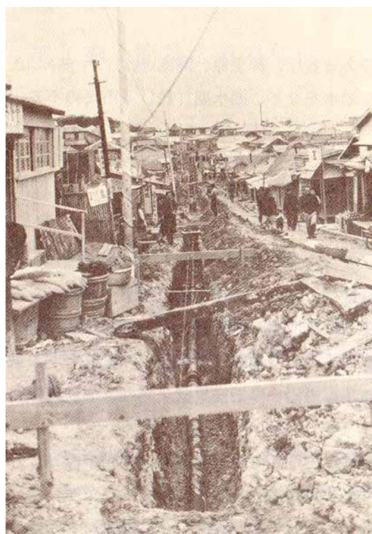
簡易水道配水管工事 (昭和26年)
