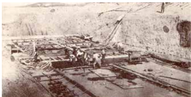
泊浄水場建設工事のようす (1932年(昭和7年)4月)
