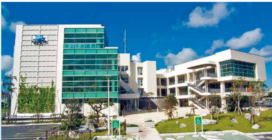
那覇市上下水道局庁舎
