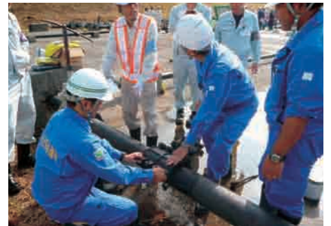
↑ 管路復旧訓練
