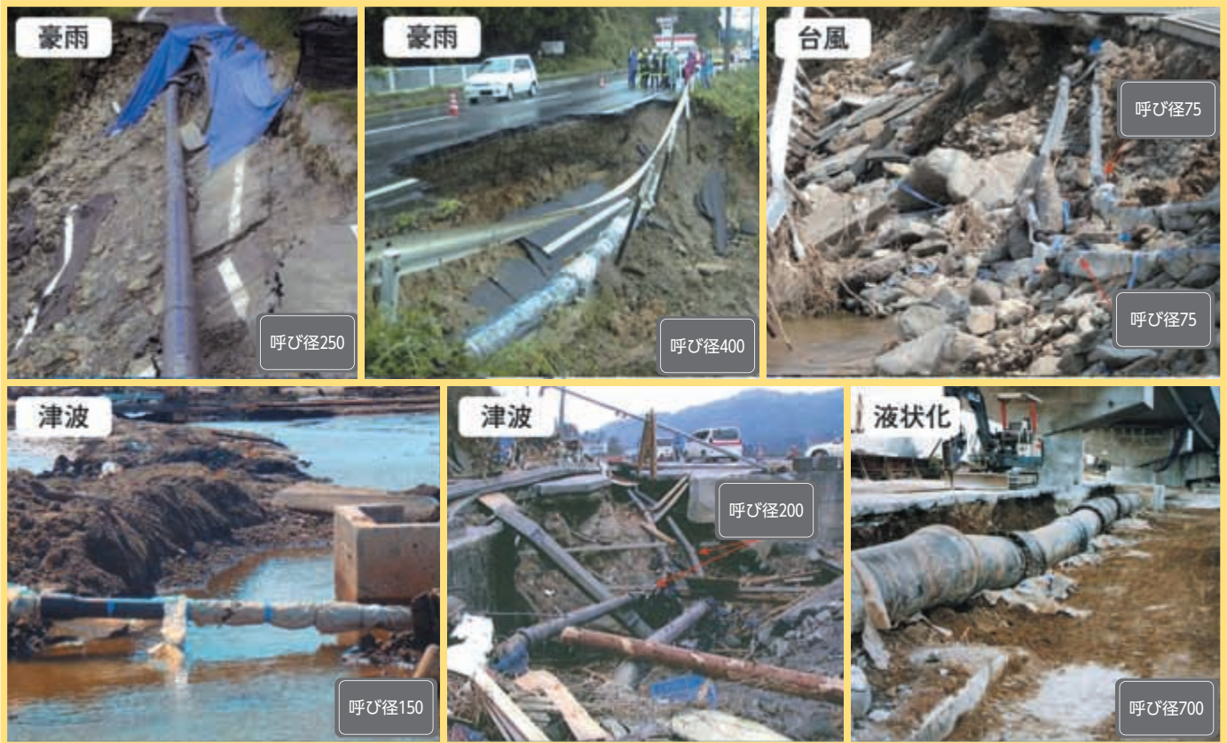
写真出典:「耐震継手ダクタイル鉄管が自然災害に耐えた事例集」-台風・豪雨・津波等による災害- 水道産業新聞 提供:一般社団法人 日本ダクタイル鉄管協会
