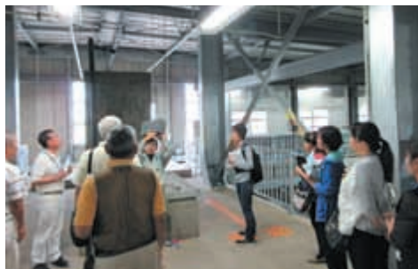
水道水ができるまでを勉強 (北谷浄水場)
