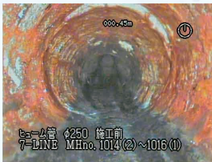
鉄筋が露出している汚水管
