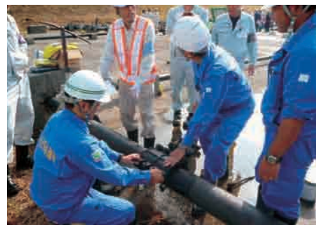
↑ 管路復旧訓練
