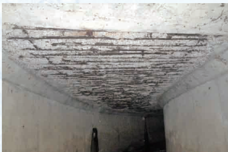
頂版の鉄筋が露出したボックスカルバート
