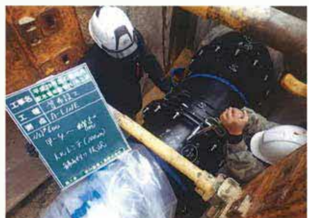
写真 - 耐震管の布設状況
