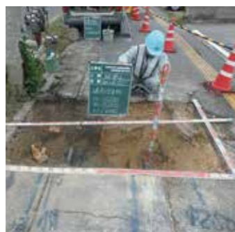
① 試掘 工事の前に他の占用物の調査をします。
