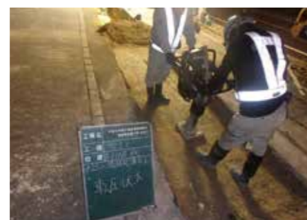
⑥ 埋戻し・締め 道路に凹凸ができないように埋戻します。
