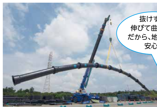
写真提供：日本ダクタイル鉄管協会
