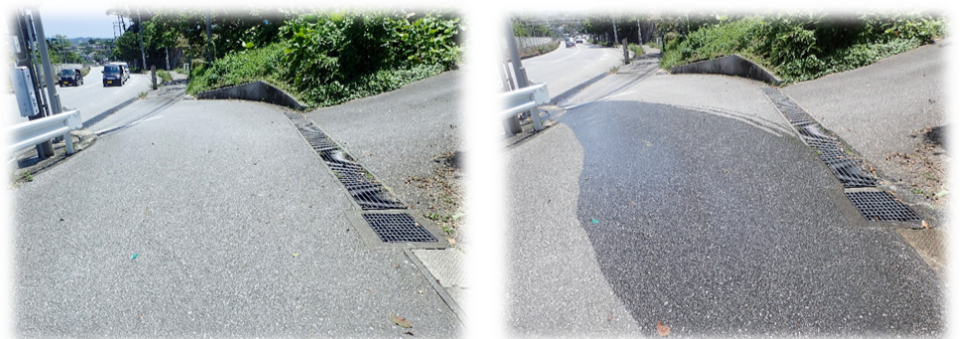
① 普段は乾いている道路の写真
