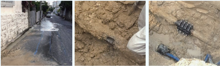
漏水箇所発見
