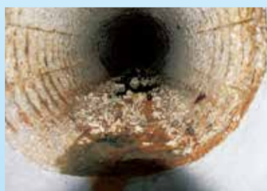
下水道管路の腐食による破損
