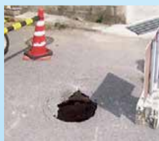
管路破損による道路陥没
