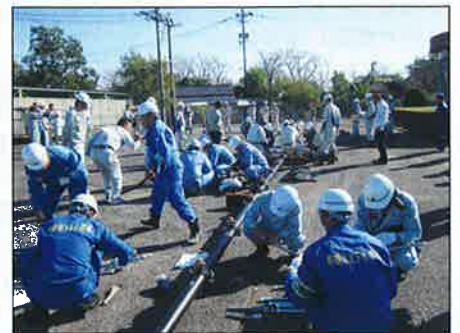
▲管路復旧訓練
