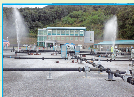
↑ 訓練用模擬管破損
