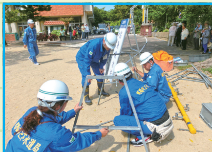
↑ 仮設給水栓設置
