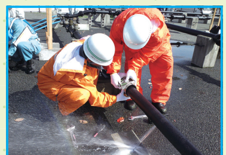
↑ 応急復旧訓練
