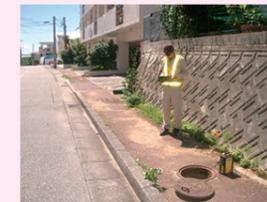
子機設置、漏水箇所測定
