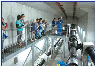
←泊配水池の内部に感動!
