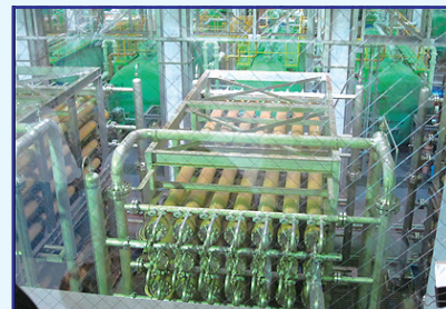
←海水淡水化施設
