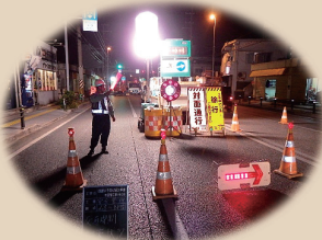
交通規制中の誘導状況
