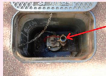
開閉時に回すバルブ等に音聴棒をあて、漏水と思われる音を聴き取ります。
