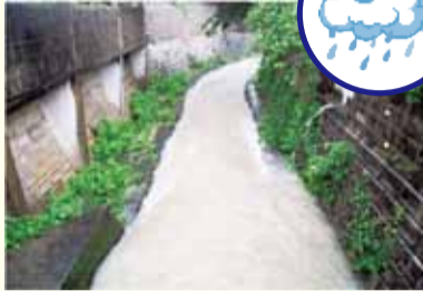
雨が降ると水路の表情が一変！濁った水が大量に水路に流れ込み水位が急上昇し水の流れも荒々しくなります。
