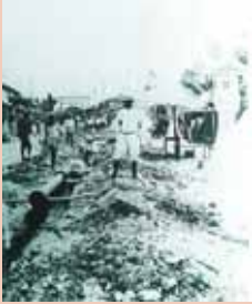
波の上一帯 配水管埋設工事
