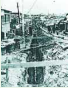
開南中央通り 簡易水道配管工事 (昭和26年)
