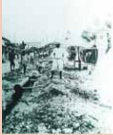
波の上ー帯 配水管埋設工事
