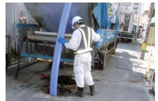
管更生工事 既設管への引き込みの様子
