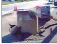
液状化によるマンホールの浮き上がり(2004年 新潟県中越地震被害状況)
