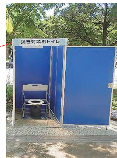
▲マンホールトイレ写真（新都心公園）
