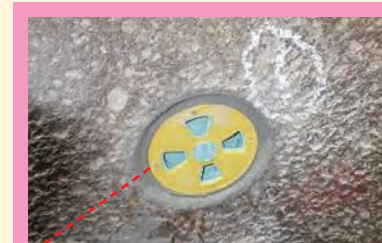
▲マンホール浮上防止対策
