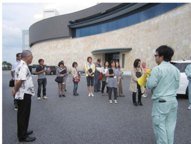
海水淡水化施設
