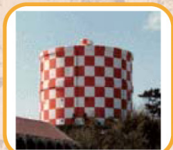
② 赤嶺配水池
