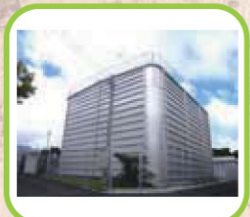
③ 上識名配水池
