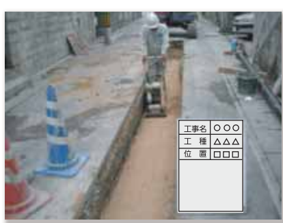
④ 埋め戻しの状況
