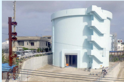
1池目完成写真
