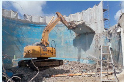
2池目解体工事の様子
