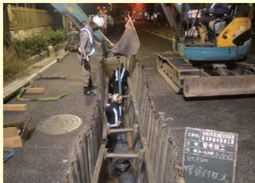
耐震管の布設状況
