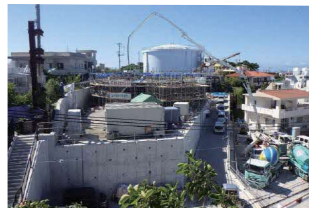
1基目施工途中
