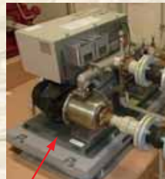
ポンプは正常に動いていますか？
