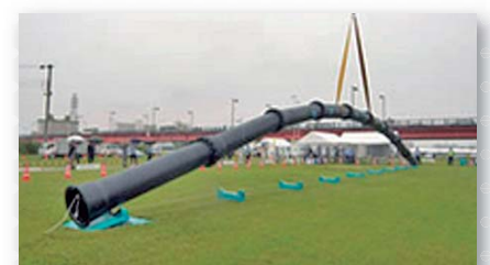
管路の吊り下げ状況
