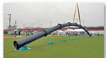
管路の吊り下げ状況
