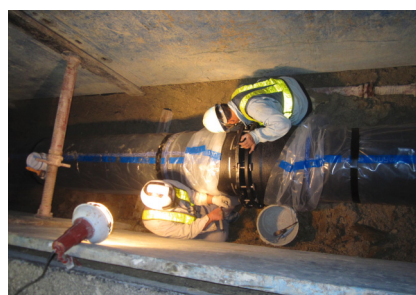
(写真6) 水道管を継いでいるところ
