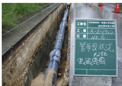
(写真2) 水道管の布設状況
