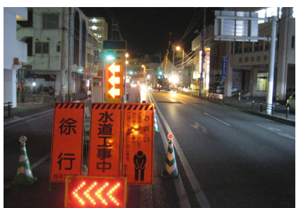
(写真4) 夜間工事中
