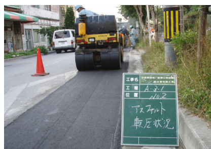
(写真3) 工事が終わり、舗装しているところ
