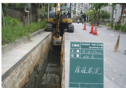
(写真1) 工事のため穴を掘っているところ
