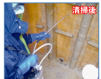
藻の発生：内壁に繁殖した藻類の膜ははがれ浮遊物が流出します。
