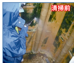
藻の発生：内壁に繁殖した藻類の膜ははがれ浮遊物が流出します。
