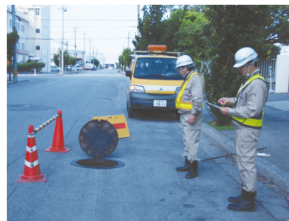
下水道のマンホール調査
