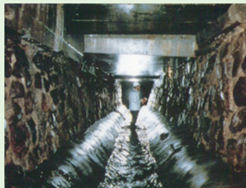
太閤下水 写真提供：大阪市建設局
