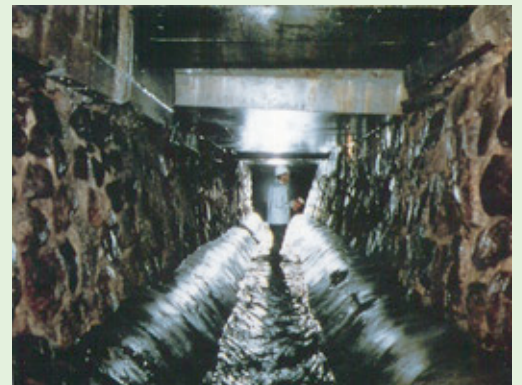
太閤下水 写真提供：大阪市建設局
