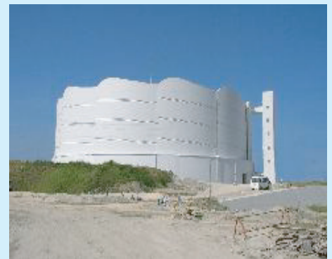
泊配水池（平成14年完成） 泊浄水場跡地に建設
