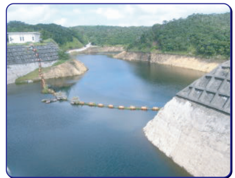
渇水時の新川ダムの様子 (写真提供：総合事務局北部ダム統括管理事務所)
