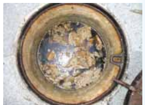
下水道管(公共樹)の中で油が固まり、排水の流れが悪くなっている様子です。
