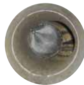
高圧洗浄中の管内部の様子
