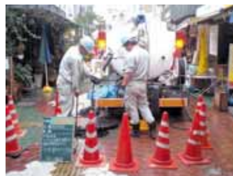
高圧洗浄車を使った清掃作業の様子
