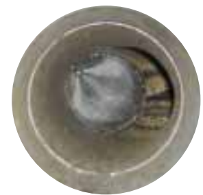
高圧洗浄中の管内部の様子
