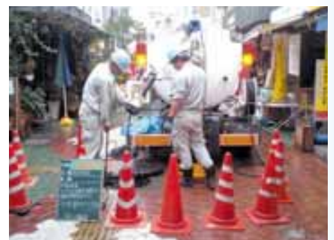
高圧洗浄車を使った清掃作業の様子
