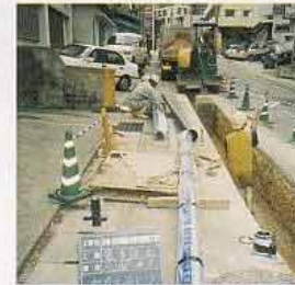
水道管を布設するために道路を掘ります。
