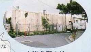
上識名配水池
