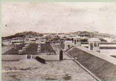
返還された泊浄水場(昭和29年)
