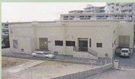
集中監視センター(平成3年完成)
