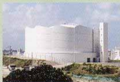
泊配水池(平成14年完成)
