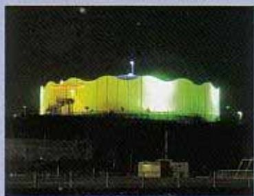
ライトアップされた安里配水池
