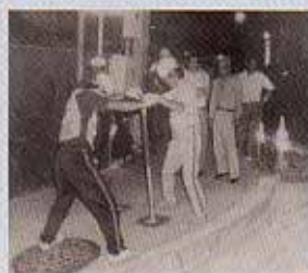
夜間の給水制限に伴う バルブ操作
