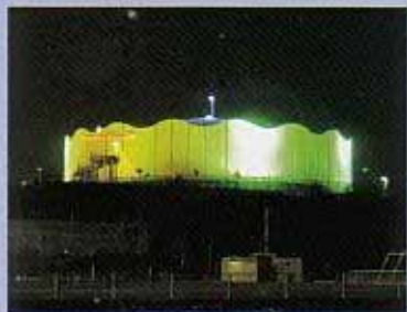
ライトアップされた安里配水池
