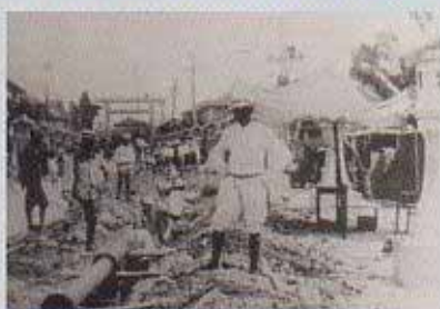
配水管埋設工事の風景(昭和7年)
