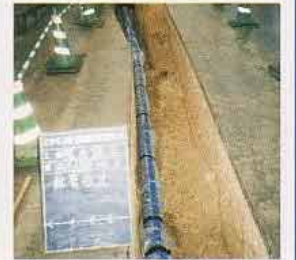
新しい水道管を布設し安定給水に努めています。
