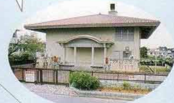
石嶺ポンプ場
