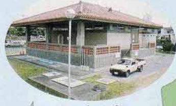
垣花ポンプ場
