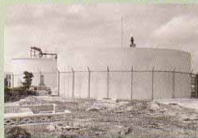
首里配水池を増設(昭和41年)
