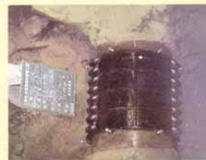
修理及び復旧
