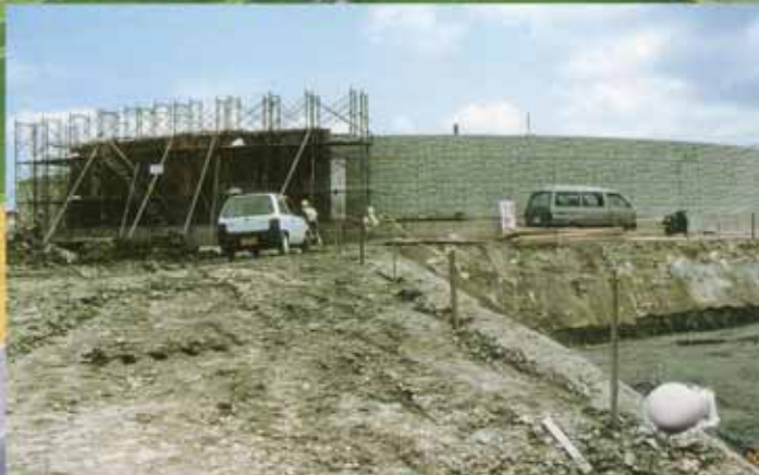
安里配水池建設現場
