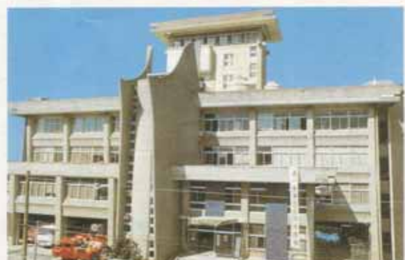
真和志水道局庁舎・知名度としては、真和志支所が上である。
